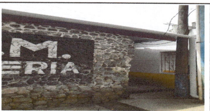
Foto 6: Sustrucción de canales y bajadas de agua pluvial de pvc en area de bodega y aula de párvulos del establecimiento.
