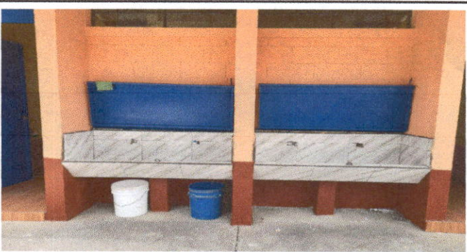
Foto 16: Sustitución de azulejo en area de lavamanos de sanitarios, hombres y mujeres.
