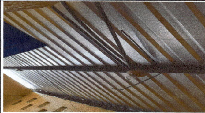
Foto 7: Reparación del sistema eléctrico en modulo de cocina.
