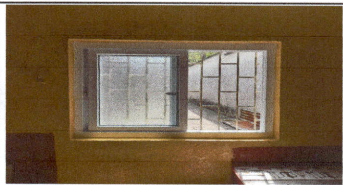
Foto 5: Sustrucción de ventana de metal por ventana de pvc en modulo de cocina.
