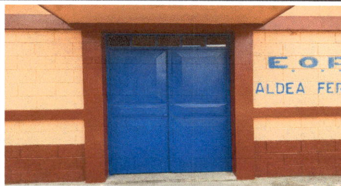
Foto 3: Puertas. Mantenimiento a estructura (lijado, cepillado, aplicación de pintura). En aulas del modulo 1 del establecimiento educativo.
