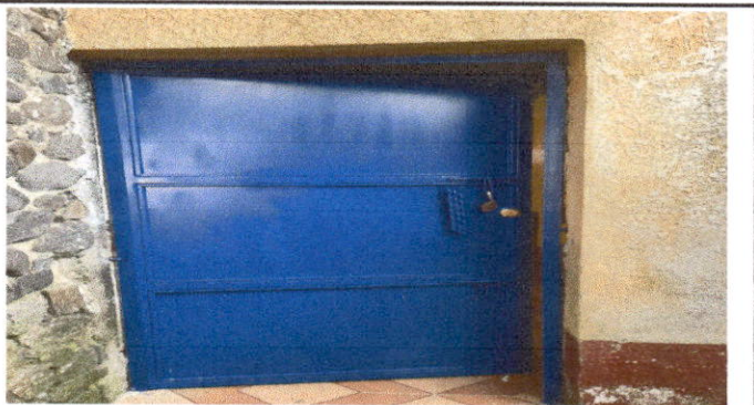
Foto 4: Fabricación e instalación de puerta de metal en modulo de cocina.
