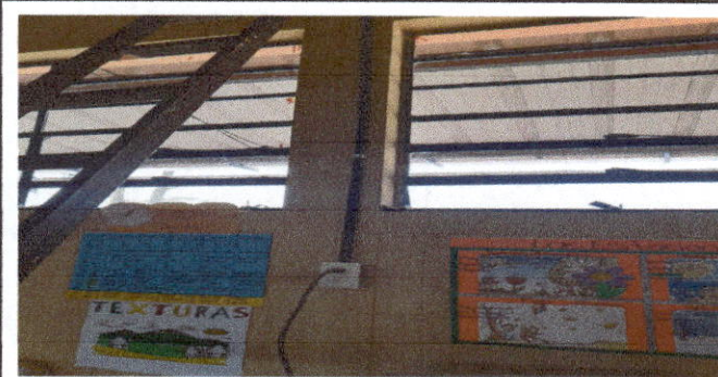
Foto 11: Reparación del sistema eléctrico más accesorios en modulo de aulas de todo el establecimiento.
