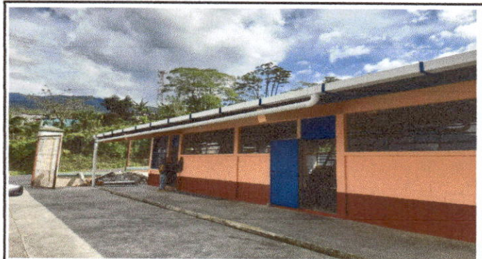
Foto 10: Sustitución de canales y bajadas de agua pluvial en modulo 2 (parte de arriba)
