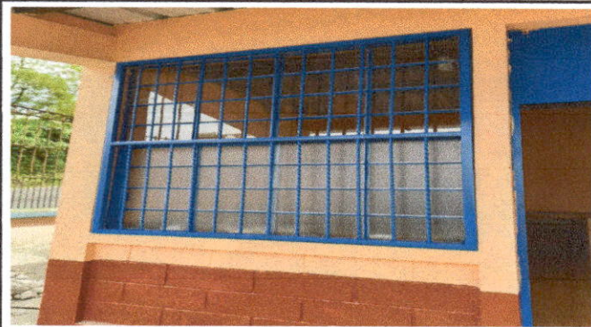
Foto 9: Mantenimiento a estructura de metal de ventana, lijado, pintura y cambio de vidrios en dirección.
