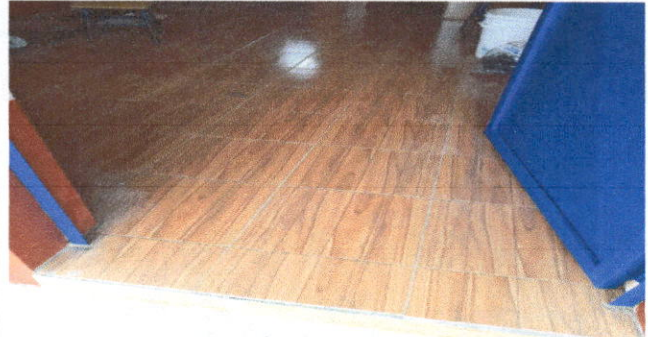
Foto 14: Sustitución de piso de cemento liquido (por piso cerámico) en modulo de dirección.
