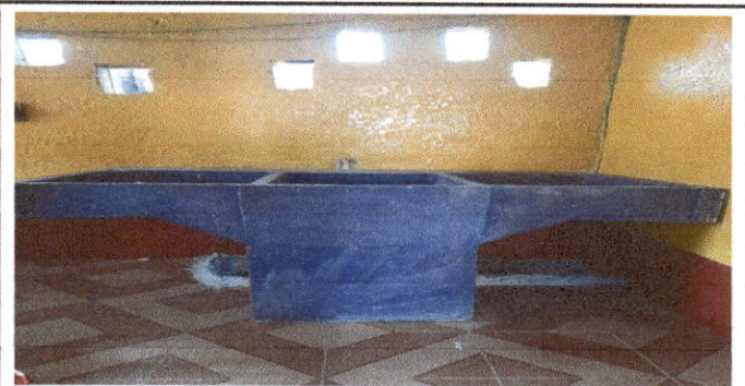
Foto 12: Instalación de pila nueva, mantenimiento de reposadera y sustitución de chorro en area de cocina.
